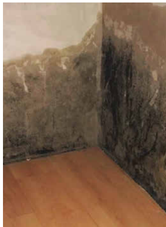
Defekte Horizontalsperre
